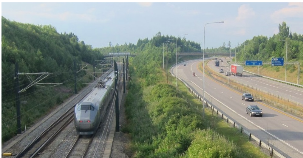
Figur 4.2: Mange steder kan det være hensiktsmessig med felles forsyning for jernbane og elektrisk vei. Foto: Eivind Molde
