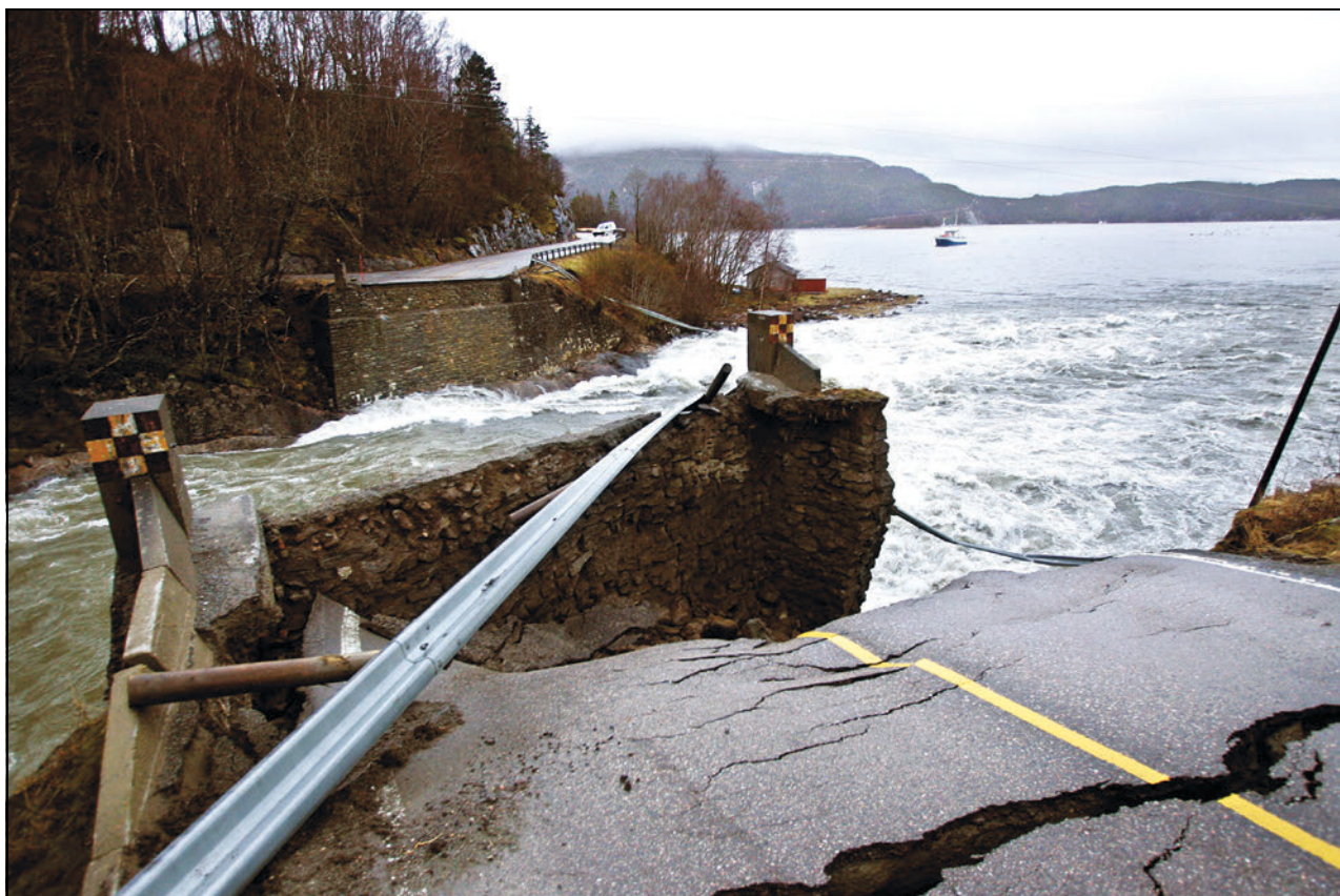
Figur 12.1 Flom i Stordalselva som rev med seg Arnevika bru på fv. 715 i Åfjord i Sør-Trøndelag.
